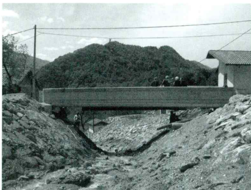
Sl. 8. Razširitev struge in gradnja novega mostu
