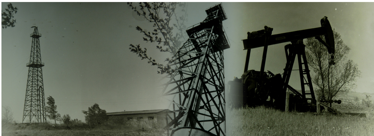
Sl. 2. Vrtalni stolp na plinski vrtini Pg-3 in površinska črpalka na naftni vrtini Pt-1 (vir: Petrol Geo, 2018).
