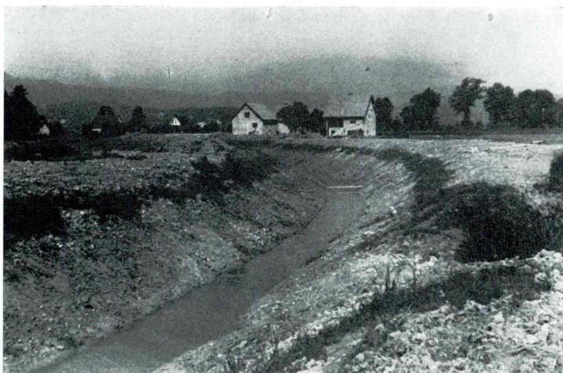
Sl. 1. — Fig. 1. Osuševalni jarek, izkopen v jezersko kreda. Vzhodno od Vrhnike. — The drainage ditch in lacustrine chalk east of Vrhnika
