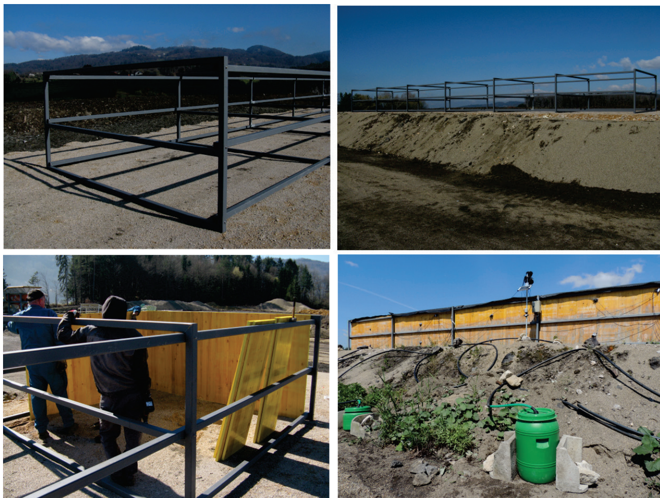
Sl. 2. Kovinsko ogrodje šestih lizimetrov, postavljeno na utrjen nasip (zgoraj), montiranje opažnih plošč na ogrodje (spodaj levo) in dokončani lizimetri z drenažnimi cevmi speljanimi do zbiralnikov ob vznožju nasipa (spodaj desno).
