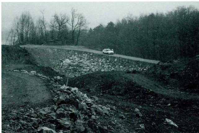
Slika 2. Kamnita pregrada za ustavitev drobirskih tokov, ki se nahaja v grapi potoka Grajšček nad vasjo Lokavec
