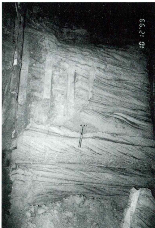
Slika 1: Navzkrižna plastovitost, stacionaža 55+270 v galeriji levo
