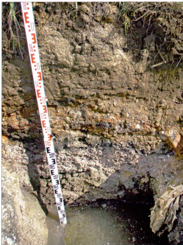
Sl. 2. Prikaz izkopa opremljenega z mersko lato
