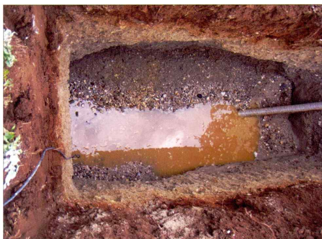
Sl. 5. Primer porušenega izkopa v spodnjem delu izkopa v prodo peščenih plasteh (foto Z. Bole)
