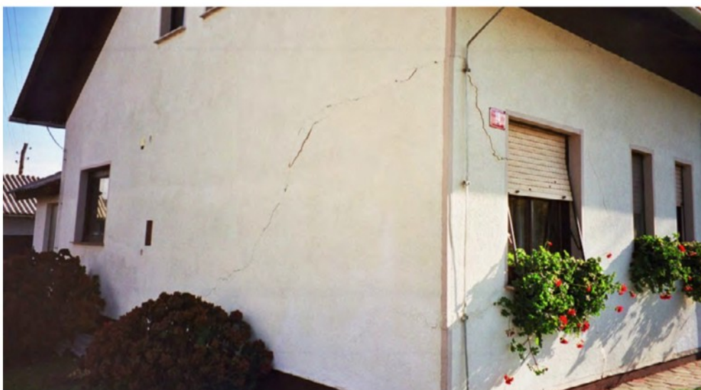
Sl. 3. Poškodbe na hiši iz centralnega dela Doline (poleg vrtnice DI-5).
