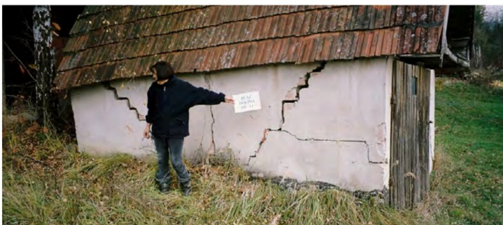
Sl. 4. Poškodbe na objektu na zahodnem delu Doline (poleg vrtnice DI-11).
