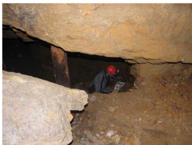
Sl. 4. Delno zarušen Janičkov rov. Vidne so subhorizontalne razpoke vzporedne starejšemu klivažu in strma prelomna površina (zgoraj). Levo spodaj je odlomljen blok brečiranega in nato še močno okremenjenega dolomita. Janičkov rov, opuščen rudnik Remšnik. Foto Z. Žorž.
