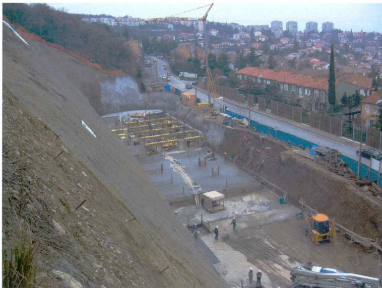
Slika 19. Pogled na dokončno izkopano brežino objektov A1 in A2, varovano s pasivnimi samovrtalnimi injektirnimi sidri do dna druge kletne etaže – podzemne garaže, kjer poteka izvedba temeljenja in opaženja prvih spodnjih sten (december 2006).
