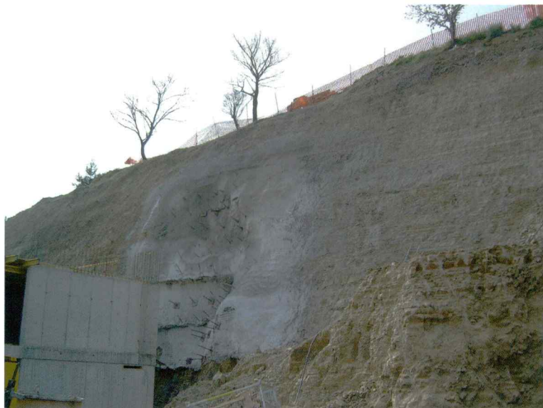
Slika 20. Na levi strani gradnja bloka »B« in saniran hribinski podor ob prelomni in oslavljeni coni, na desni strani izkop pod rezervoarji Rižanskega vodovoda v območju objekta »AB«.
