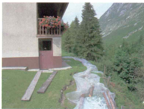
Slika 10. Nastanek dolge razpoke ob robu terase na levem bregu Soče v vasi Soča (Soča 98).
