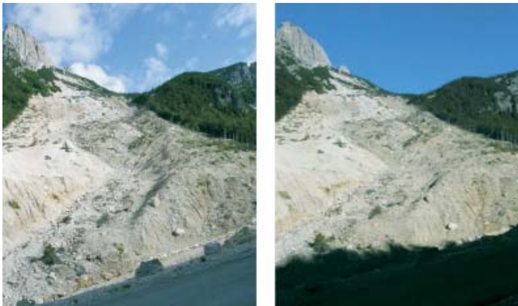
Slika 17. Pogled na plaz Stovže nad Logom pod Mangartom 13. julija 2004 (levo) in 26. septembra 2003 (desno) nam kaže, da potresni sunek na plaz ni vplival.
