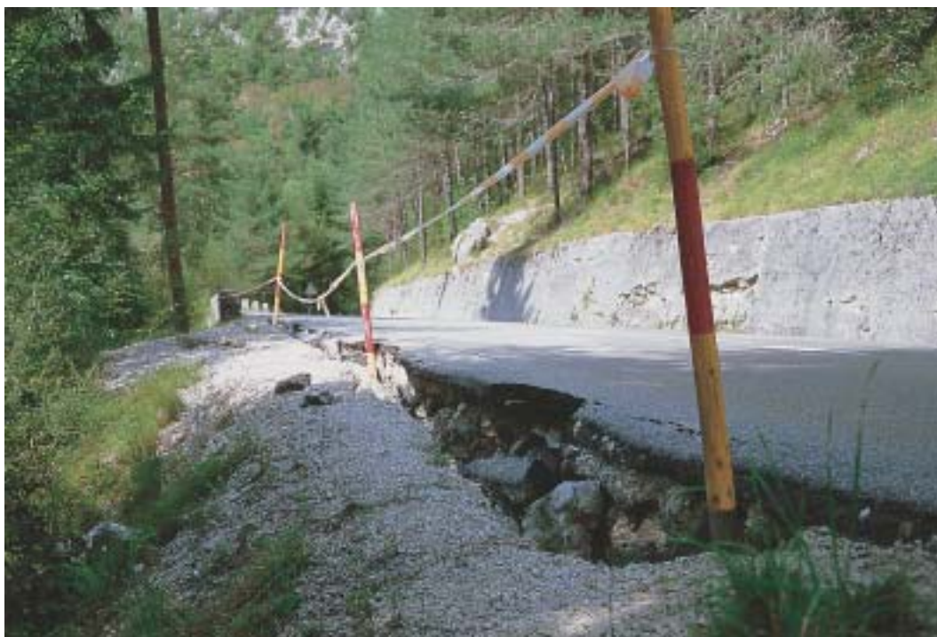
Slika 13. Posedek ob strmem bregu na robu ceste v bližini Golobarske žičnice.
