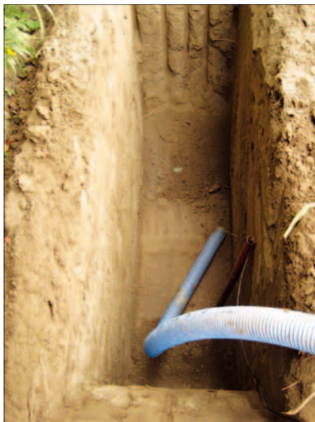
Sl. 3. Izkop pripravljen na izvajanje ponikalnega poizkusa – dotočna cev z zaščito sonde (foto Z. Bole)
