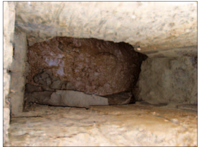
Sl. 4. Primer porušenega izkopa v spodnjem delu pod slabo prepustnim pokrovom (foto T. Matoz)
